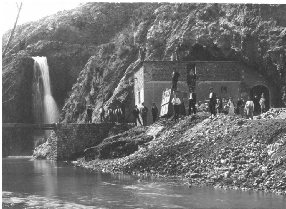
Construyendo la casa del molinero (1930 aproximadamente).
