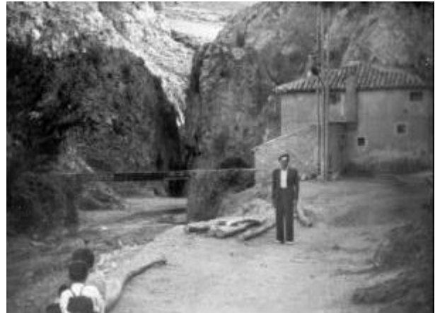
Exterior del molino de la Cueva y parte de sus instalaciones eléctricas. Fotografía de Amparo Artigas.
